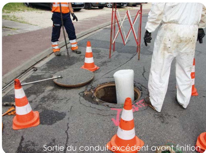
Mise en place du dispositif de raccordement
